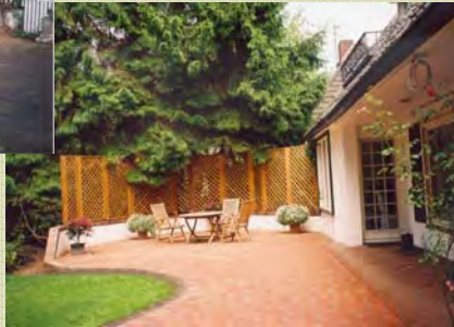
Nachher Gördingklinker rot 10/10cm im Kreuzfugenverband
