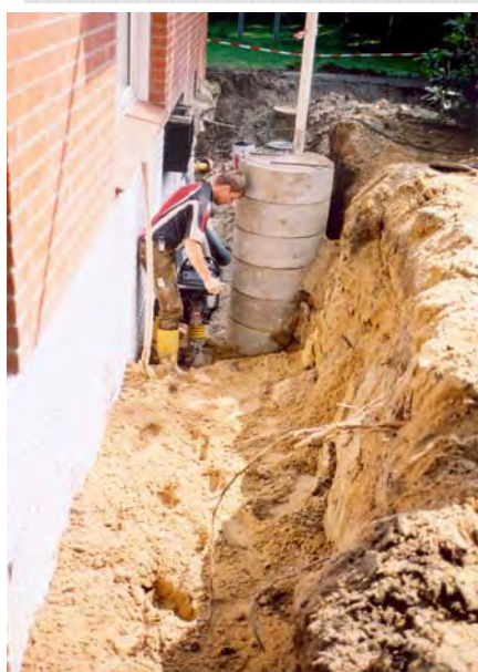
Betonstütze zur Abfangung der Balkone
