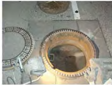
Verguss mit Bitumen
