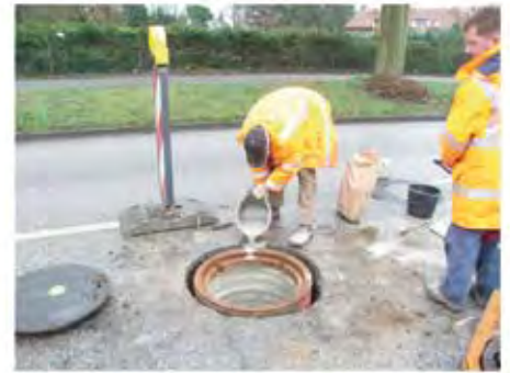
Vergießen mit schnell (1 Std.) aushärtendem Mörtel
