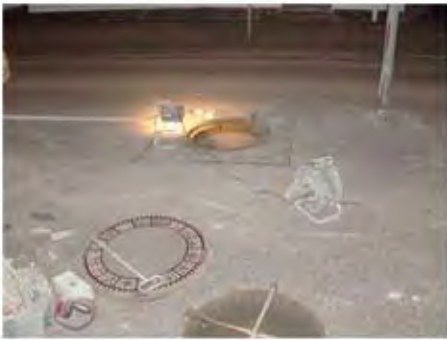
Reparatur des Pflasters um den Schacht
