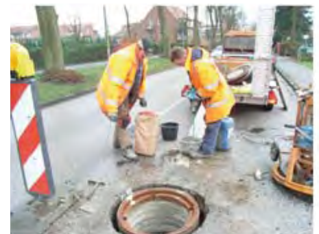
Anrühren des Quellmörtels
