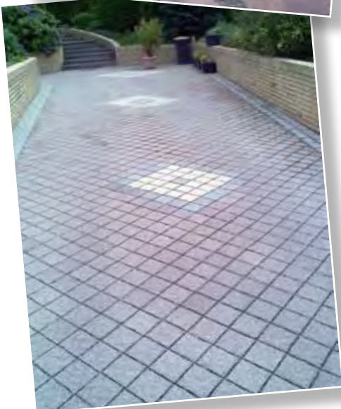
Hauszufahrt aus Betonziegpflaster
